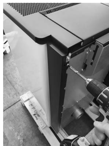
Fig. 38 - Fissare il fianco completo
